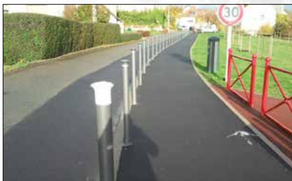
Mise en place de potelets rue Almeth pour la sécurité des piétons
