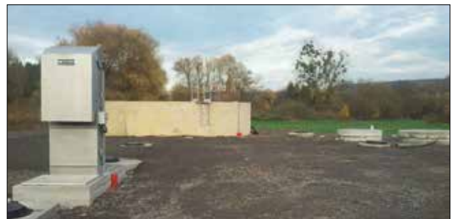
Nouvelle station d'épuration rue de Sarrebruck
