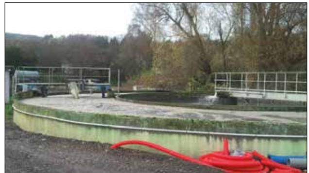
Ancienne station d'épuration rue de Sarrebruck
