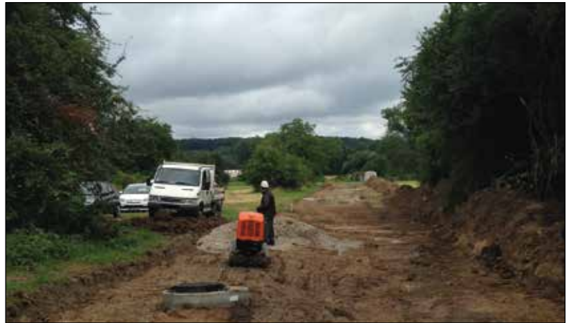
Pose des conduites de refoulement de la station d'épuration
