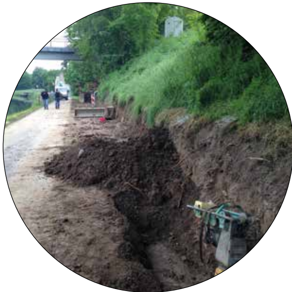
Travaux d'assainissement chemin de halage.
